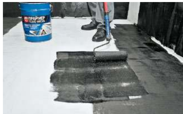
Рисунок 3.5. – Нанесение праймера
