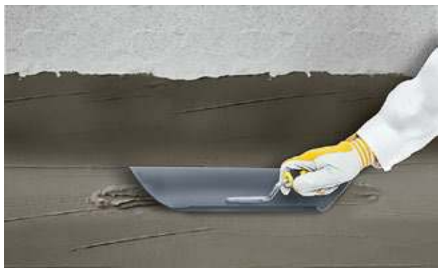
Рисунок 3.3. – Устройство выкружки
