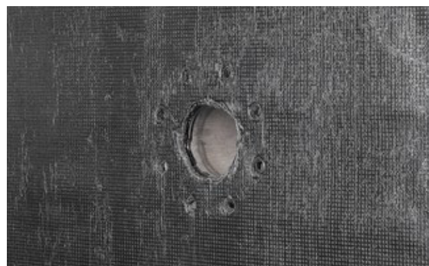
Рисунок 6.12. – Раскладка рулонов первого и второго слоя Техноэласт ЭПП в зоне трубной проходки
