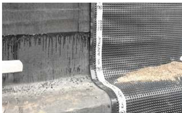
Рисунок 4.20. – Защита гидроизоляционной мембраны профилированной мембраной PLANTER standard и экструзионным пенополистиролом XPS ТЕХНОНИКОЛЬ CARBON PROF
