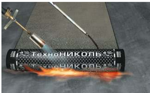
Рисунок 4.8. – Наплавление рулона
