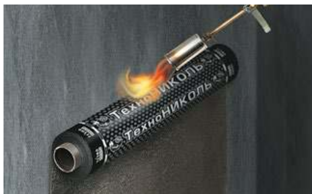
Рисунок 4.18. – Наплавление битумно-полимерного рулонного материала на вертикальную поверхность
