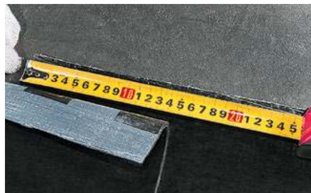
Рисунок 4.4. – Контроль торцевого нахлеста при укладке материала Техноэласт ЭПП
