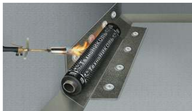
Рисунок 5.7. – Наплавление рулона на слой усиления
