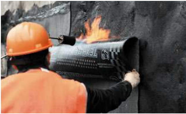
Рисунок 2.3. – Метод сплошного наплавления
