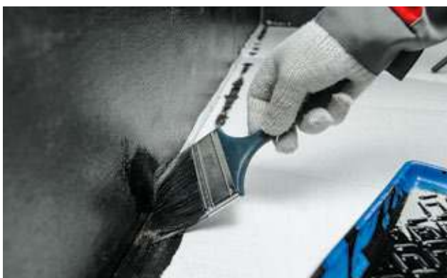
Рисунок 3.7. – Нанесение праймера кистью в зоне угла
