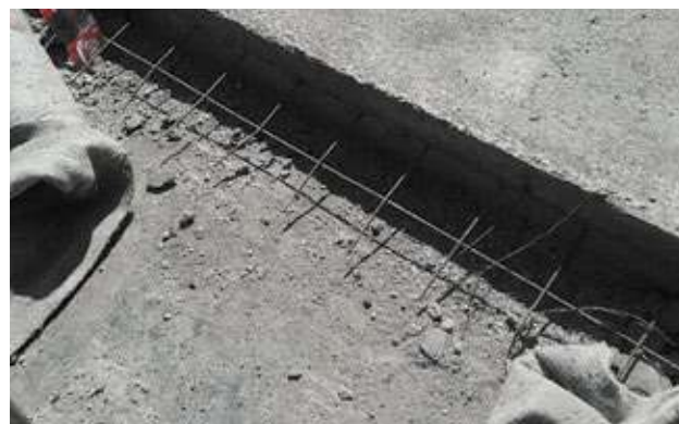
Рисунок 4.11. – Защитная стяжка
