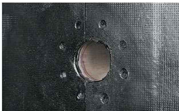
Рисунок 6.12. – Раскладка рулонов первого и второго слоя Техноэласт ЭПП в зоне трубной проходки
