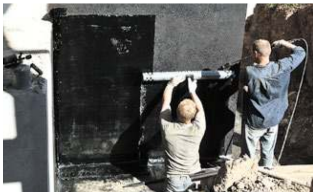
Рисунок 4.17. – Ручная и механическая подача рулона
