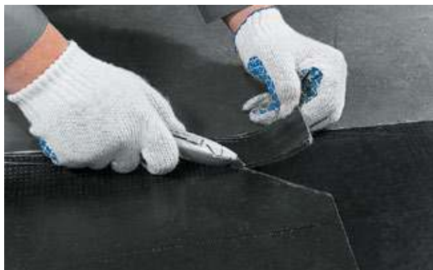
Рисунок 4.5. – Подрезка угла рулона в Т-образном шве
