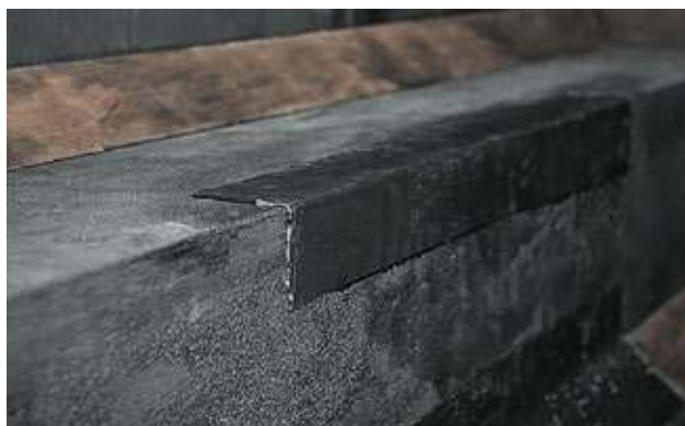
Рисунок 4.3. – Слои усиления на внешнем угле при смене плоскости наплавления
